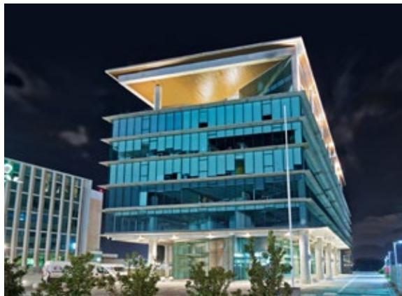
Edificio Bío Bío, Concepción, Chile Oficinas
